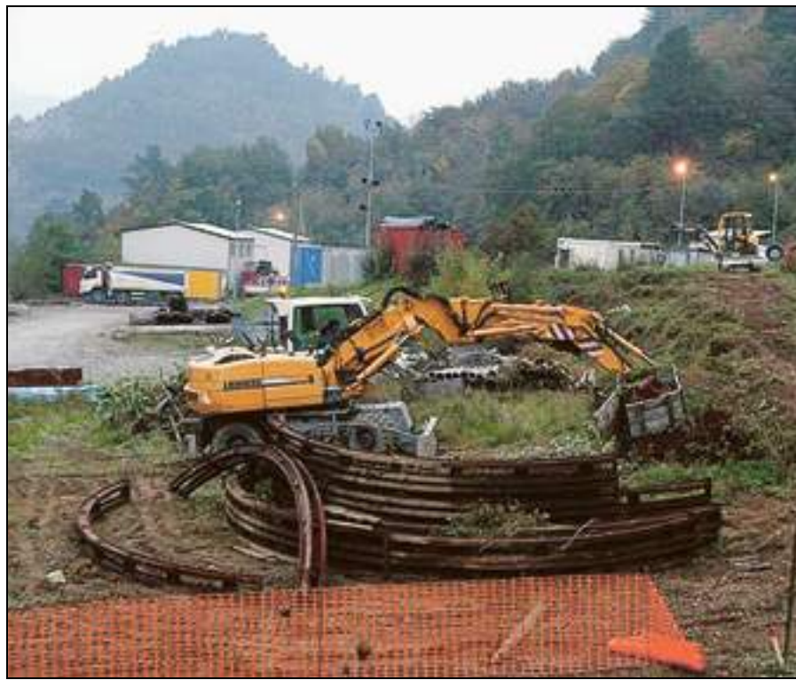
Una ruspa al lavoro per le opere preparatorie al Terzo valico
